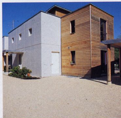
Tournée côté lac comme une muraille de béton, la façade nord est percée de quelques ouvertures volontairement minimalistes.
