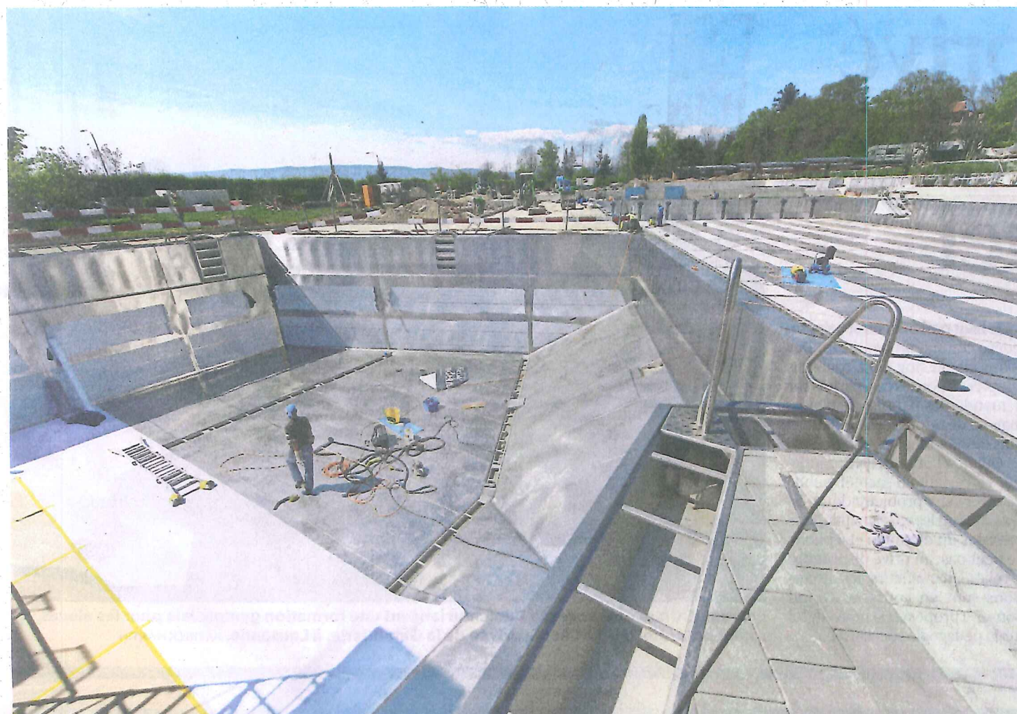
Entièrement refaits, le bassin des plongeurs et la piscine olympique de la Fleur-de-Lys étaient les vedettes des portes ouvertes organisées samedi par la Commune de Prilly. Le chantier budgété à 14,1 millions aura duré plus d'un an. JEAN-PAUL GUINNARD
