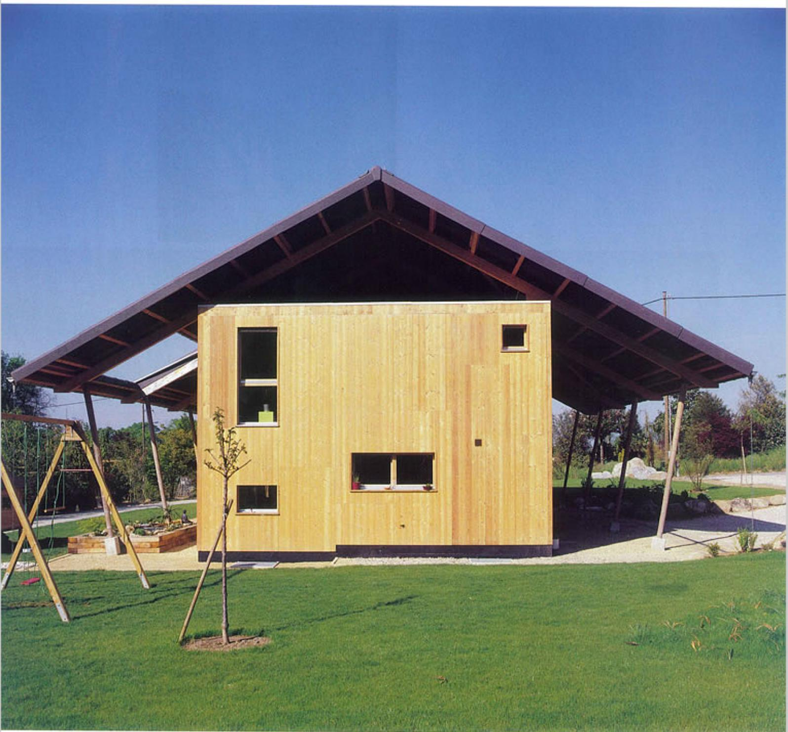
**Grande image** La structure du bâtiment est réalisée en panneaux de mélèze contrecollés.
