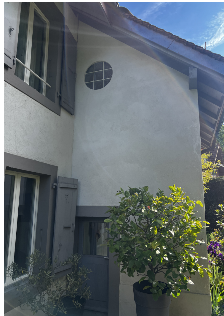
Changement menuiserie du RDC et de l'oeil de boeuf Changement des garde-corps
