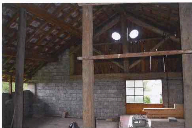
La rénovation a impliqué la reconstitution intégrale de l'étage qui servait à entreposer le foin.
