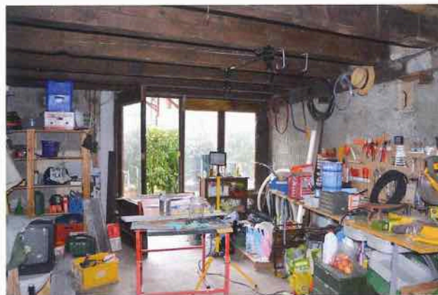
L'angle nord-est au rez de la grange avant travaux, servant d'atelier.
