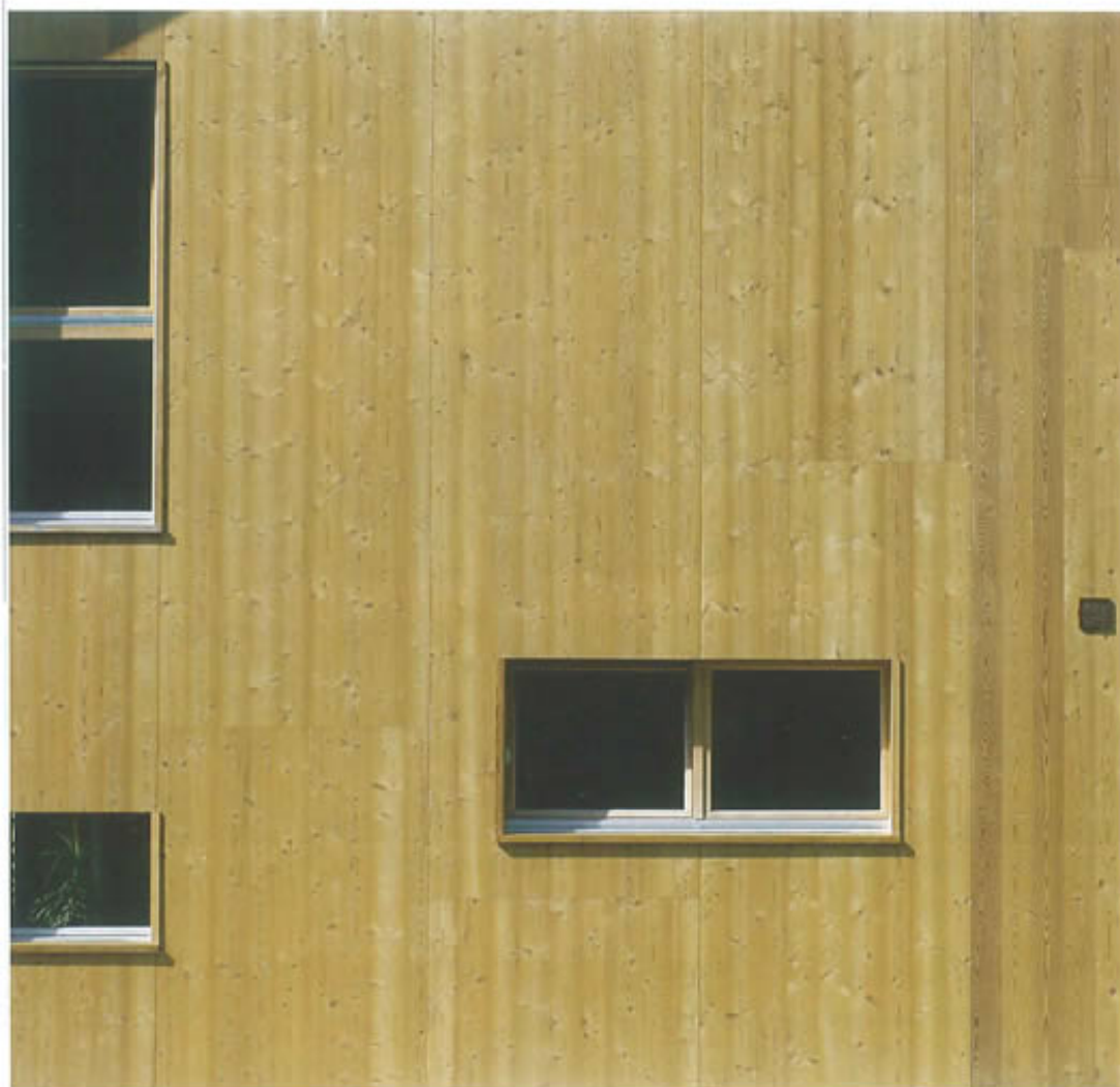
Vue sur la façade arrière qui possède peu d'ouvertures pour se protéger du froid en hiver.
