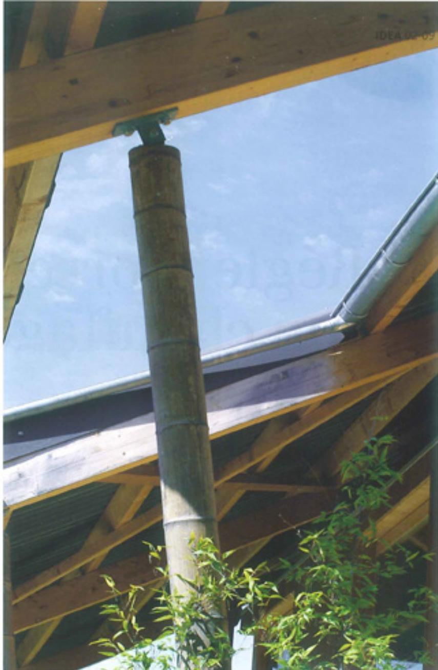
Les poteaux de bambou de soutien sont reliés à la toiture par une attache métallique.
